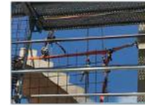
Hoch- und Tiefbau (Positionierungsarbeit)
